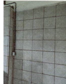
Foto 2: Instalación de piso cerámico. Se instaló piso cerámico en la cocina y en las paredes de la misma.
