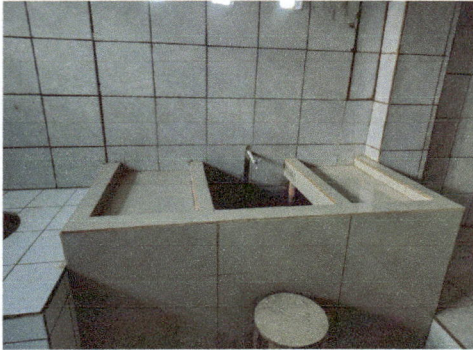
Foto 1: Construcción de pila. Se hizo una pila y se forró con azulejo. Se instaló el servicio de agua y drenaje.
