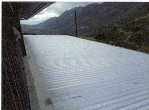
Foto 1: Estructura y entechado instalado.
