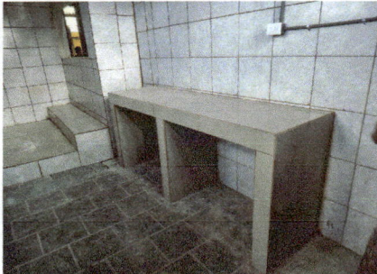
Foto 3: Construcción de mesa. Se construyó una mesa y se forró de cerámico.
