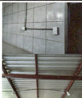
Foto 5: Instalación eléctrica. Se realizó la instalación eléctrica en la cocina, en el corredor y baños.
