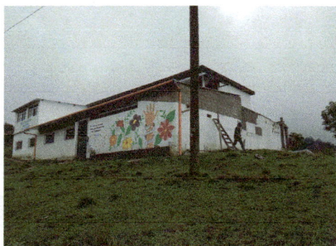
Foto 3: Instalación de canales. Se colocó canales para la caída de agua pluvial.
