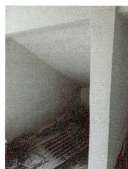
Foto 4: Aplicación de monocapa en las paredes de la cocina.
