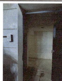
Foto 6: Instalación de puerta nueva en la cocina.
